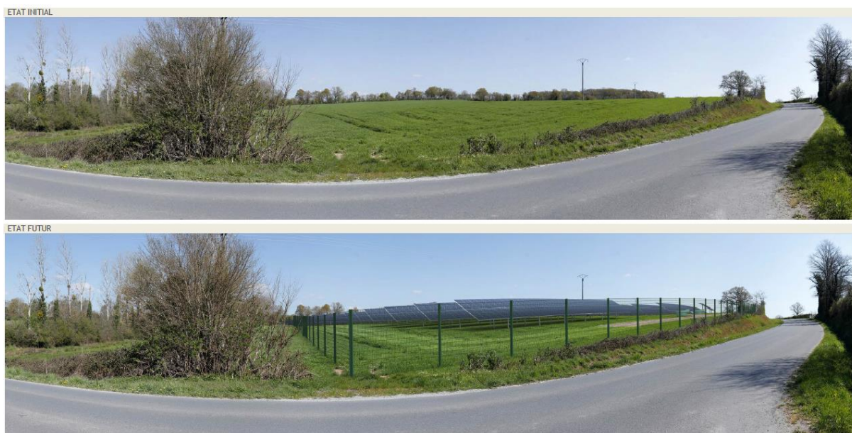
Figure 7 : photographies du site avant/après mise en place des panneaux PV depuis la Grande-Roche (avant mesures)
